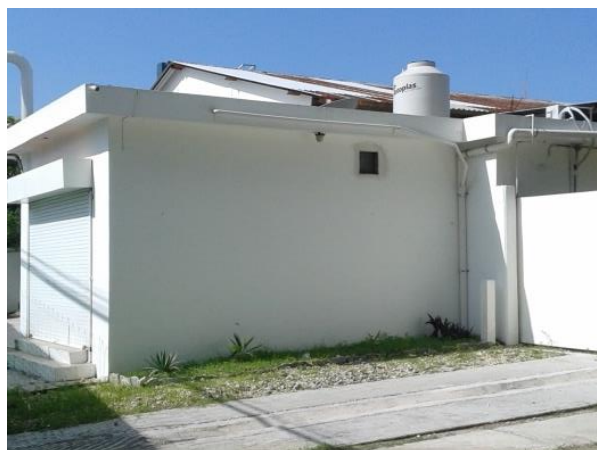
Área de almacén
