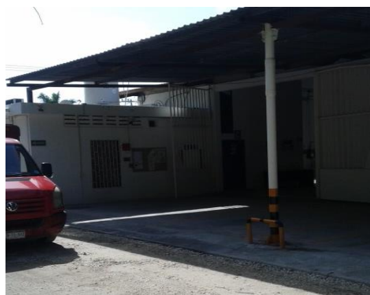
Almacén de fluidos y zona de maniobras
