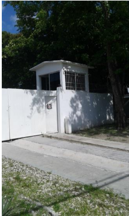
Caseta de vigilancia de la empresa
