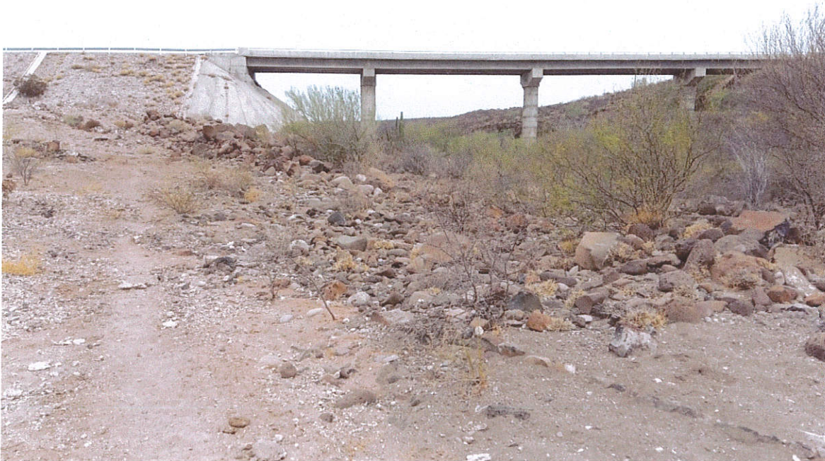
Foto 32. Cauce del arroyo San Juan inmediato aguas abajo al puente San Juan. Toma desde el banco de préstamo original.
