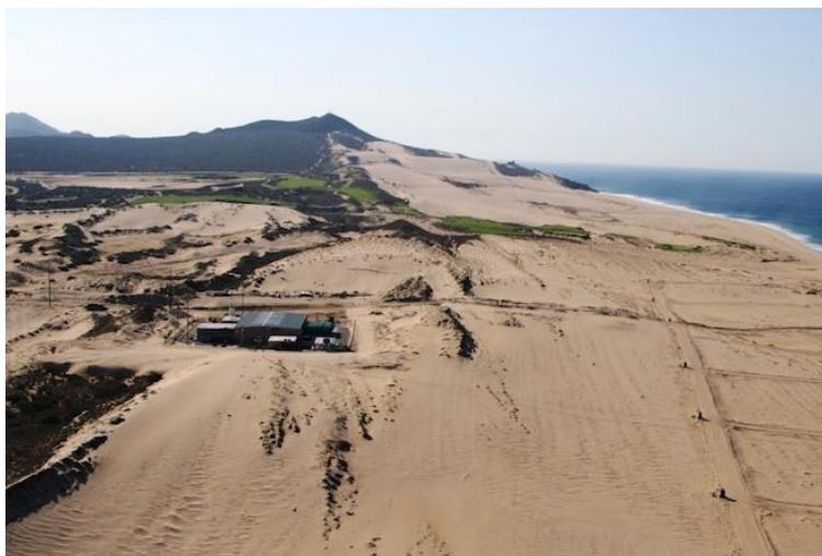
Figura 6. Planta Desaladora en operación, se observan los pozos de absorción de donde se extrae el agua para ser desalada.
