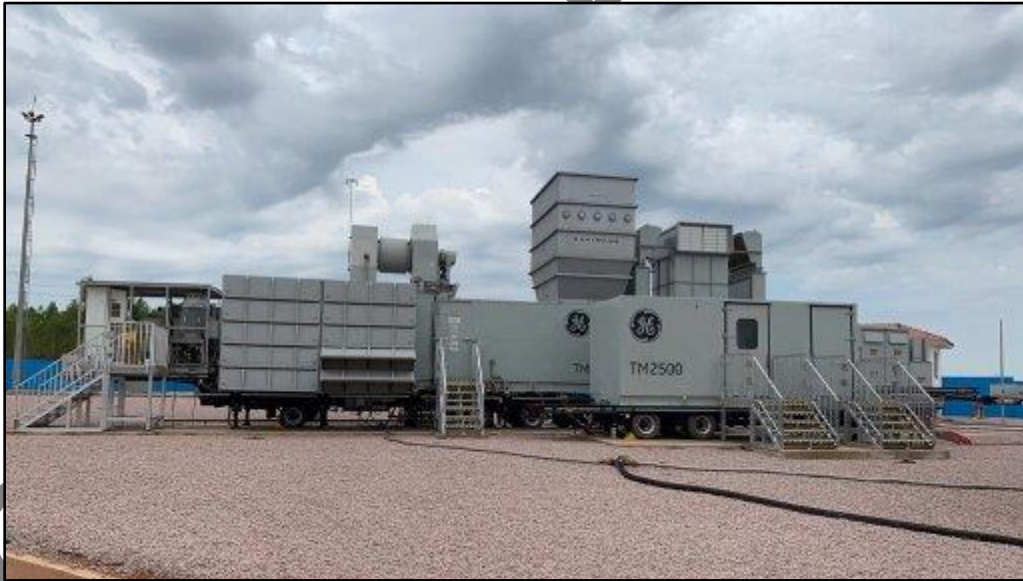
Figura 24: Ejemplo del Sistema TM2500 en operación
