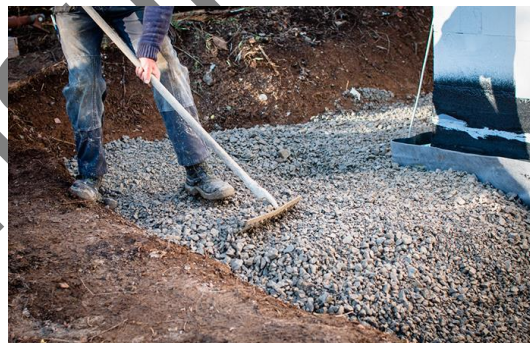
Figura 14: Acondicionamiento del terreno con grava
