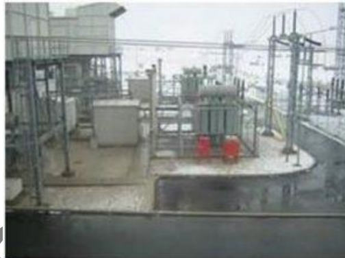
Figura 22: Ejemplo de Bahía colectora y su transformador principal
