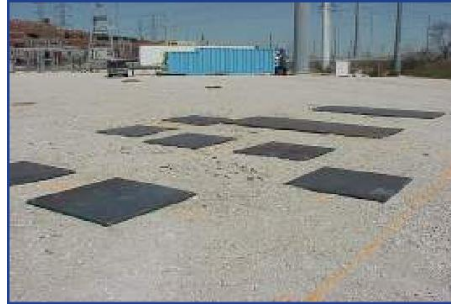
Figura 15: Placas de Acero a las que se anclarán los Tráileres y Patines
