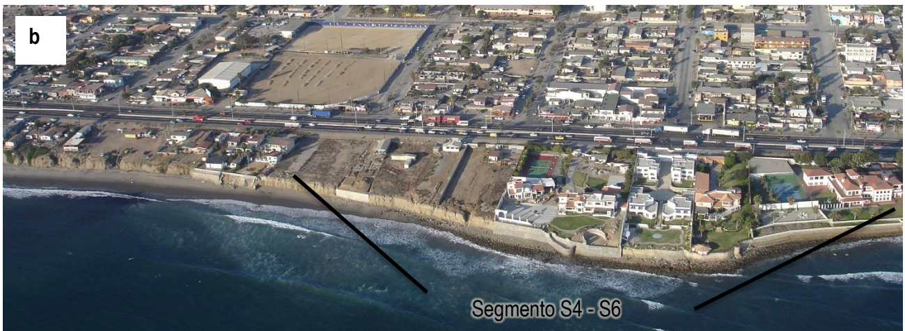
Figura 43. Rasgos morfológicos de la zona Sur de la celda litoral I (S4-S6) a) cantiles activos y muros del segmento S1-S4 y b) playa rocosa y muro en el segmento S4-S6
