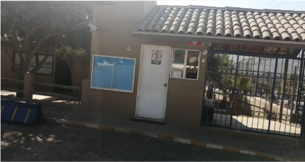
Fig. 7 Caseta de vigilancia y oficinas
