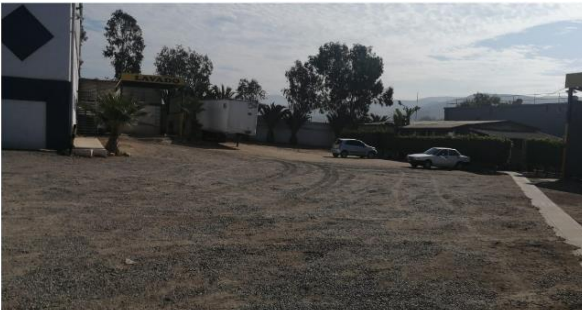
Fig.11 Vista de las instalaciones
