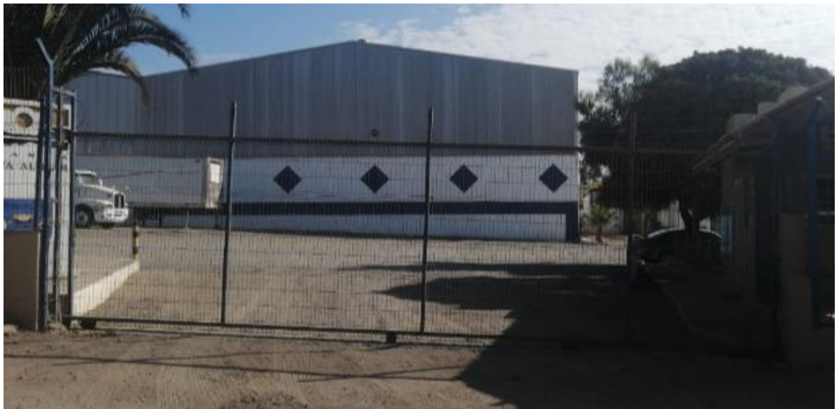
Fig. 6. Portón de Acceso a las instalaciones
