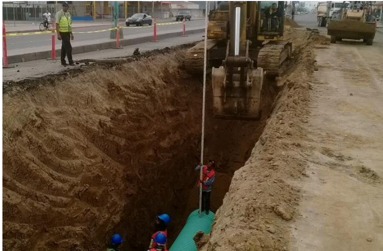
FIGURA II- 66 RELLENO DE LA ZANJA
