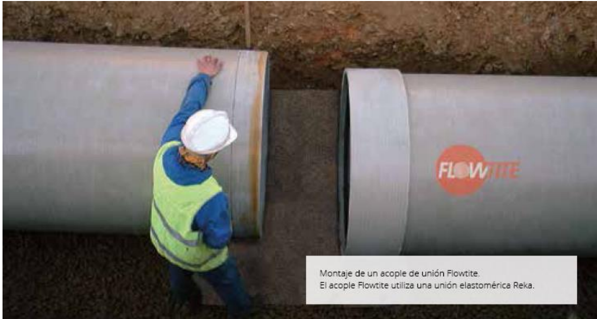
FIGURA II- 65 MONTAJE DE LA TUBERÍA
