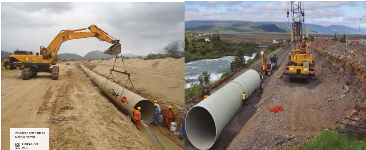
FIGURA II- 64 FORMA DE DESCENSO DE LA TUBERÍA
