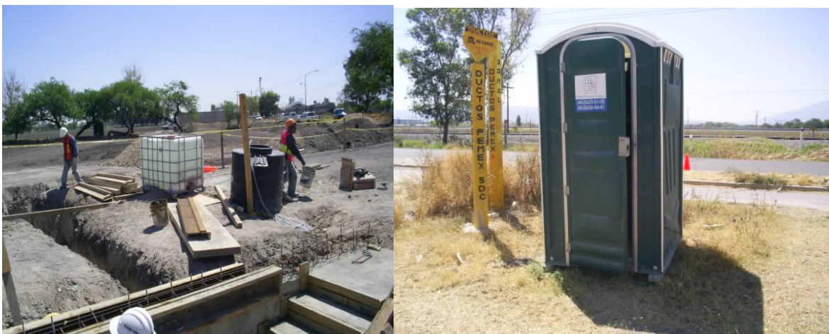
FIGURA II- 73 SE INSTALARÁN SANITARIOS PORTÁTILES Y CONTENEDORES PARA AGUA
