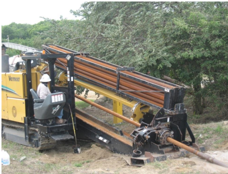
FIGURA II- 59 MÁQUINA DE PERFORACIÓN DIRECCIONAL
