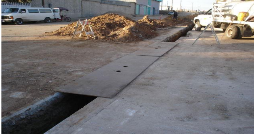
FIGURA II- 48 EJEMPLO DE INSTALACIÓN DE PLACAS DE ACERO
