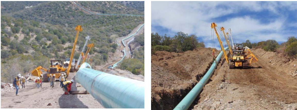
FIGURA II- 45 RECEPCIÓN DE TUBERÍA (FOTOS DE REFERENCIA DEL TIPO DE ACTIVIDADES QUE SE REALIZAN PARA RECEPCIÓN DE TUBERÍAS EN DUCTOS)
