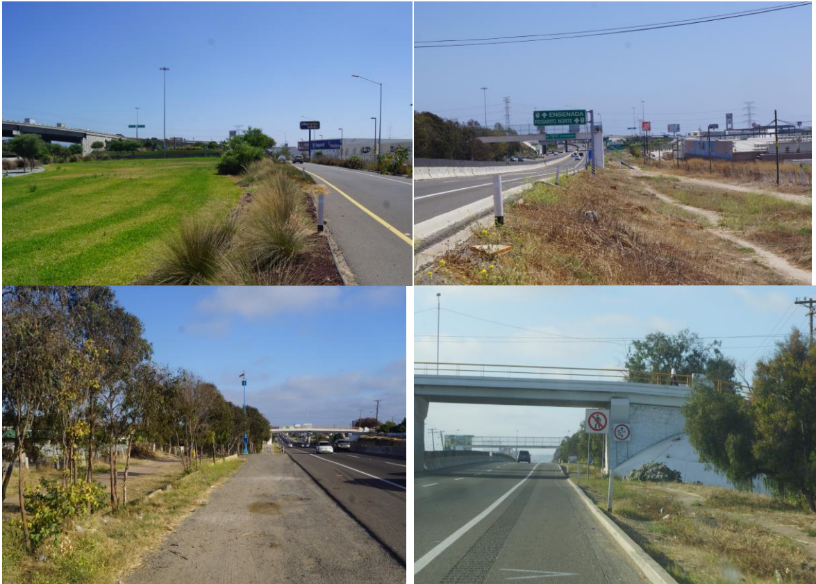
FIGURA II- 18 CONDICIONES DEL DERECHO DE VÍA DEL TRAMO KM. 011+200 AL KM 025+520 DEL ACUEDUCTO DEL PROYECTO AGUA PARA EL VALLE DE GUADALUPE
