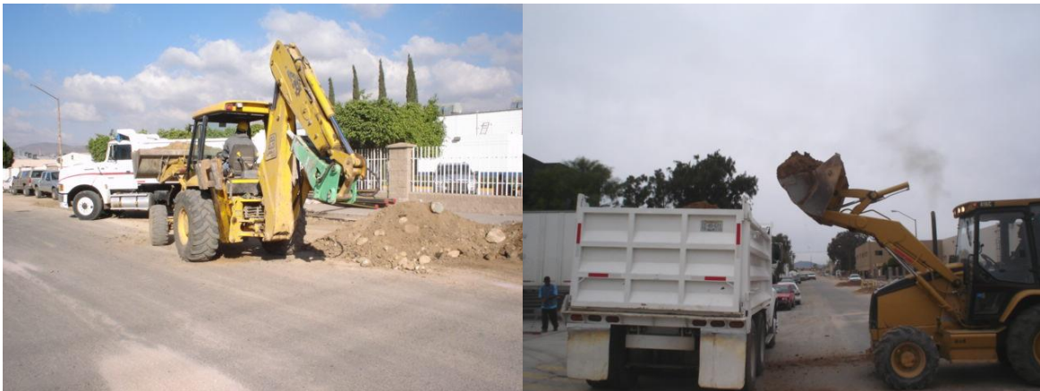
FIGURA II- 70 SE REALIZARÁ RETIRO DE MATERIAL PRODUCTO DE LA EXCAVACIÓN.
