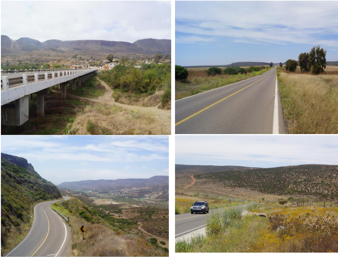
FIGURA II- 29 CONDICIONES AMBIENTALES DEL TRAMO DEL KM 060+000 AL KM 075+580
