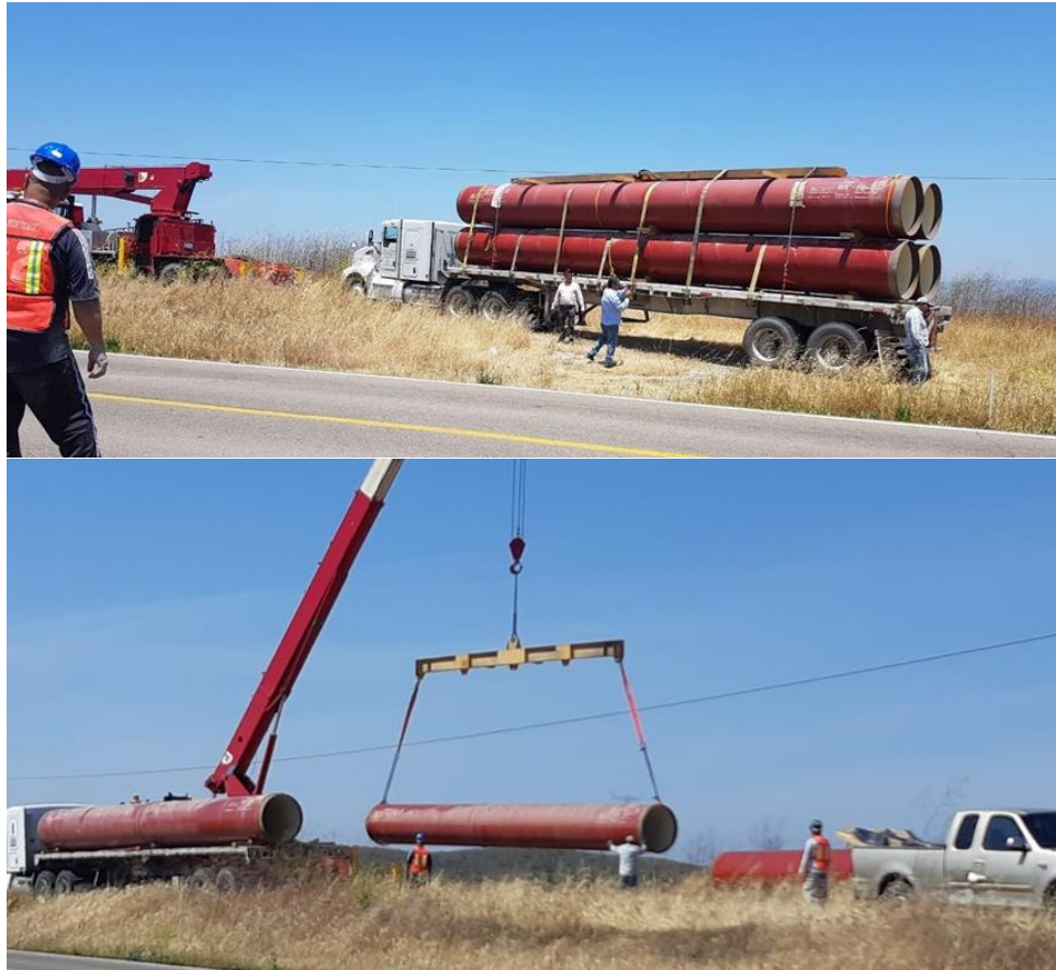
FIGURA II- 46 IZAJE Y MANEJO DE LA TUBERÍA
