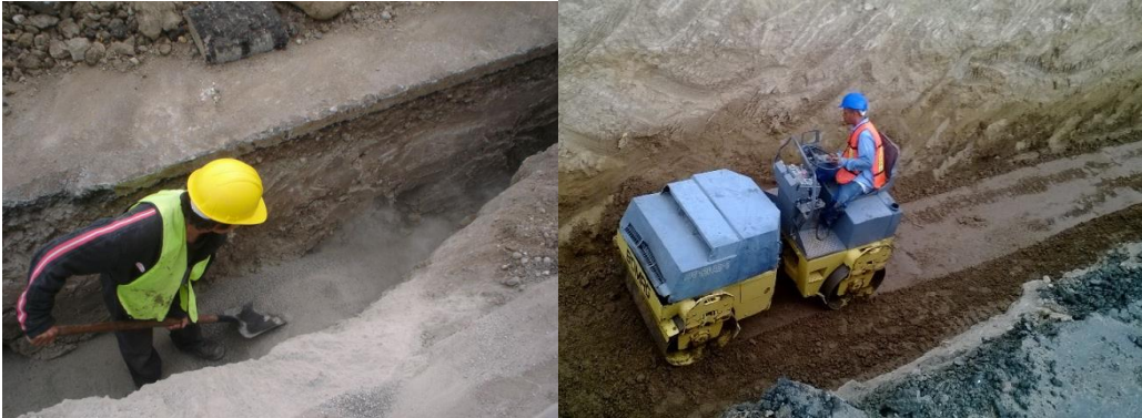
FIGURA II- 62 ACTIVIDADES PARA LA PREPARACIÓN DEL FONDO DE ZANJA DEL ACUEDUCTO DEL PROYECTO AGUA PARA EL VALLE DE GUADALUPE
