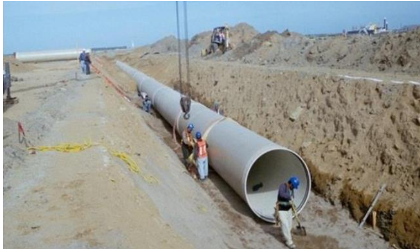
FIGURA II- 63 EJEMPLO DE TENDIDO DE LA TUBERÍA DENTRO DE LA ZANJA.
