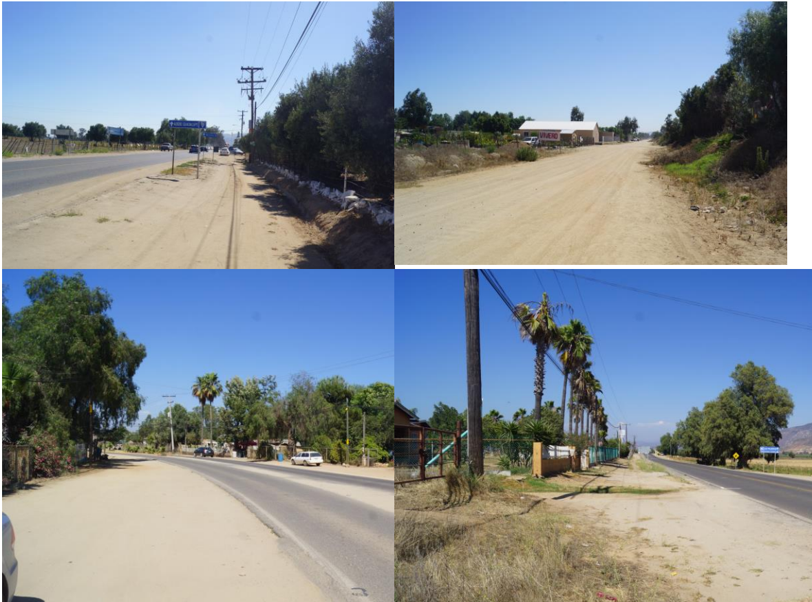
FIGURA II- 40 CONDICIONES DEL TRAMO FINAL HASTA EL KM 111+103 DEL PROYECTO AGUA PARA EL VALLE DE GUADALUPE
