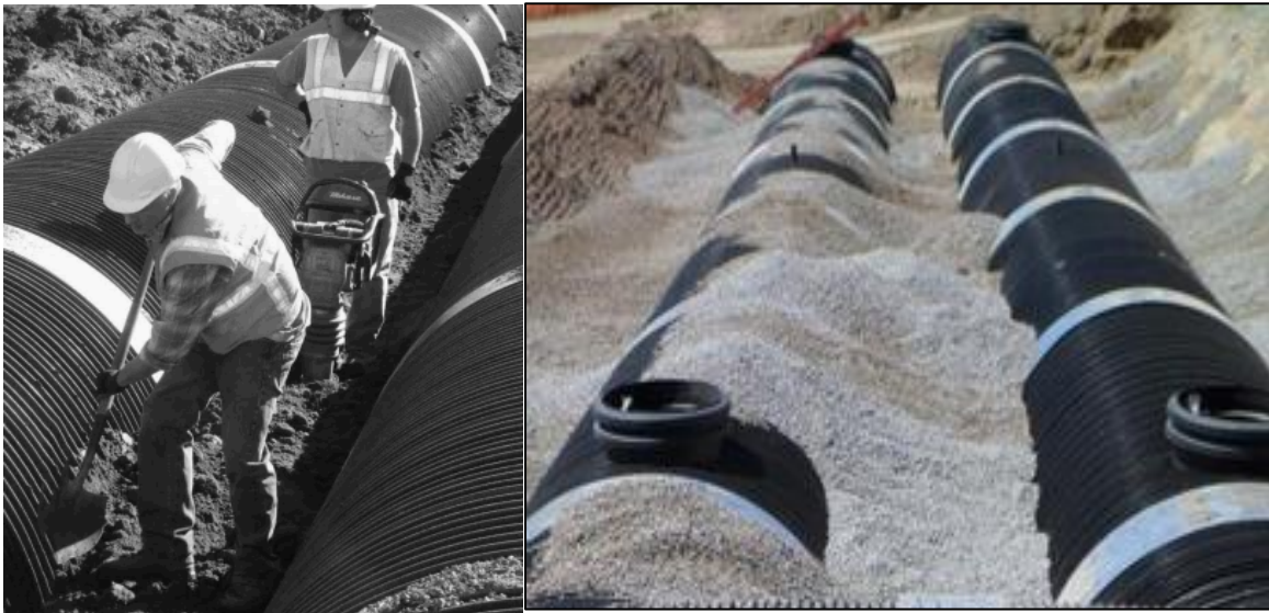
FIGURA II- 67 RELLENO Y COMPACTACIÓN
