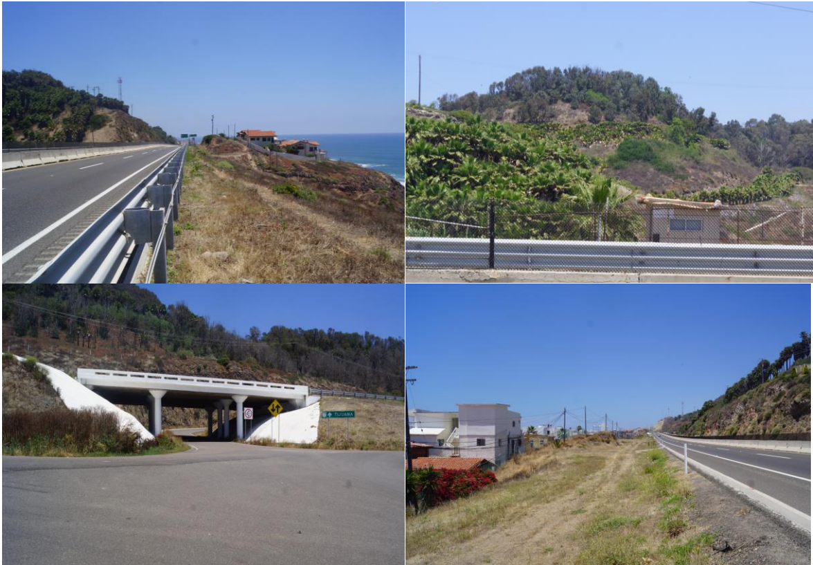
FIGURA II- 15 CONDICIONES DEL TRAMO EN LOS CADENAMIENTOS DEL ACUEDUCTO KM 005+000 AL KM 010+000 DEL PROYECTO AGUA PARA EL VALLE DE GUADALUPE
