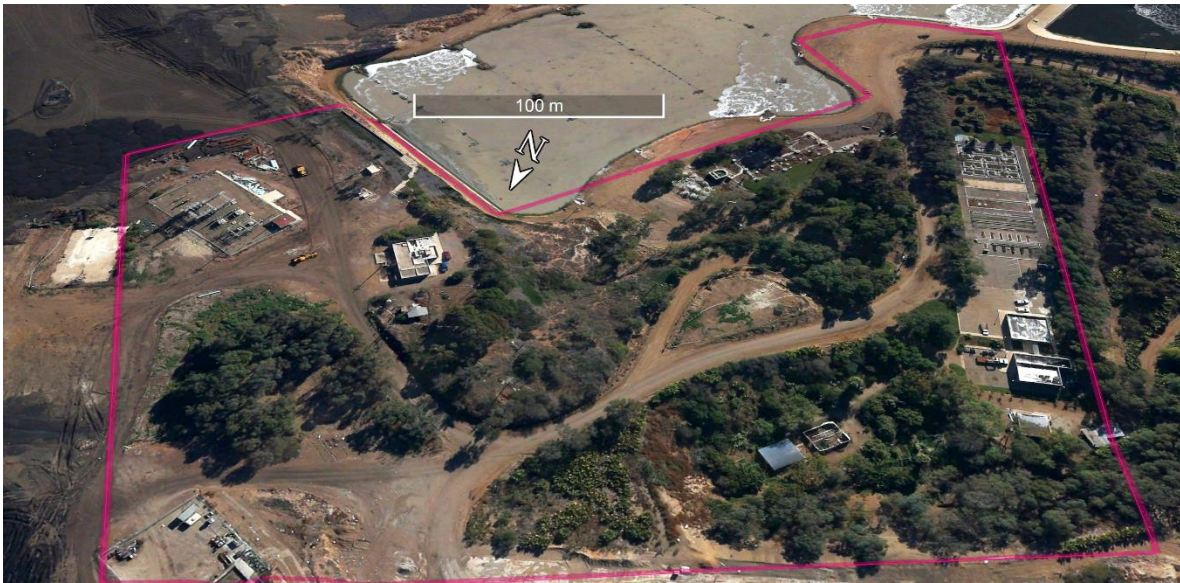
FIGURA IV- 15 ASENTAMIENTOS HUMANOS (SE MUESTRA ASENTAMIENTOS QUE CONFORMAN EQUIPAMIENTO Y LA HUELLA DONDE SE UBICA LA PTAR ACTUAL EN EL SAR
