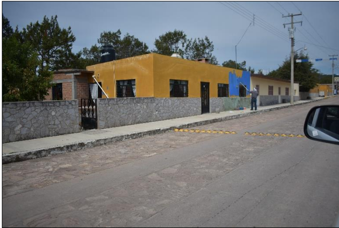
Foto 13. Calle principal de la comunidad por donde sigue el trazo de la línea de conducción hasta llegar al predio del yanque elevado
