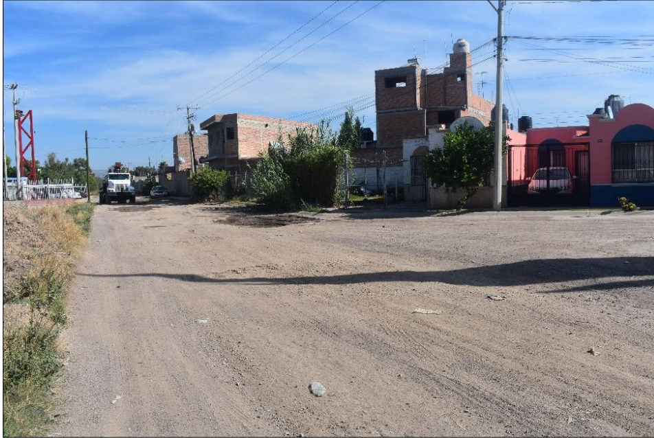
Fotografía 16. Planta de Tratamiento abandonada en la calle Moluca
