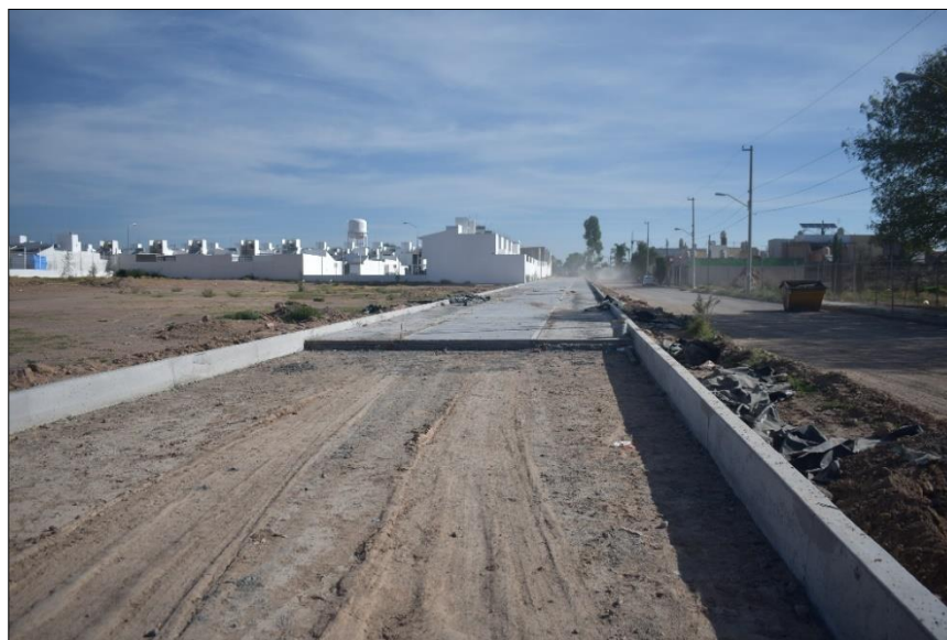
Fotografía 1. Inicio de colector sanitario en Av. Paseos de Aguascalientes
