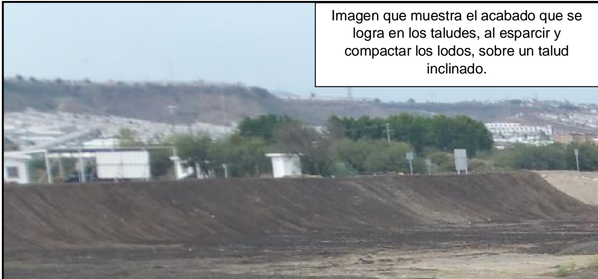
Figura 39. Ejemplo de operación en la compactación y acomodo de lodos.
